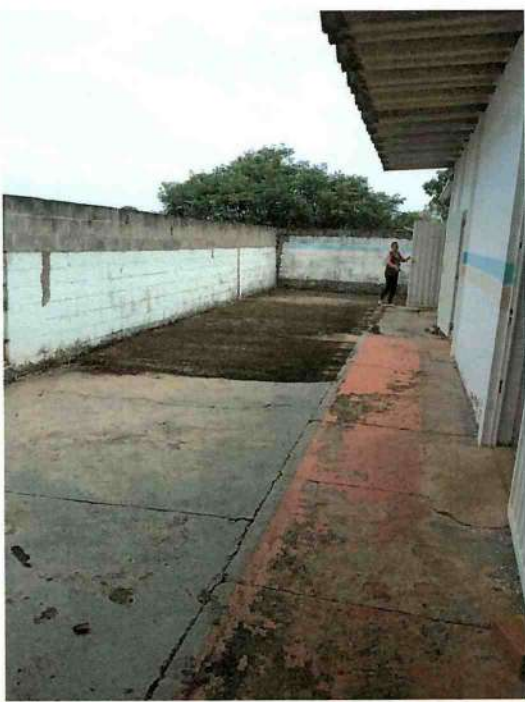
Imagem 2: Área destinada para ampliação de sala de atendimento
