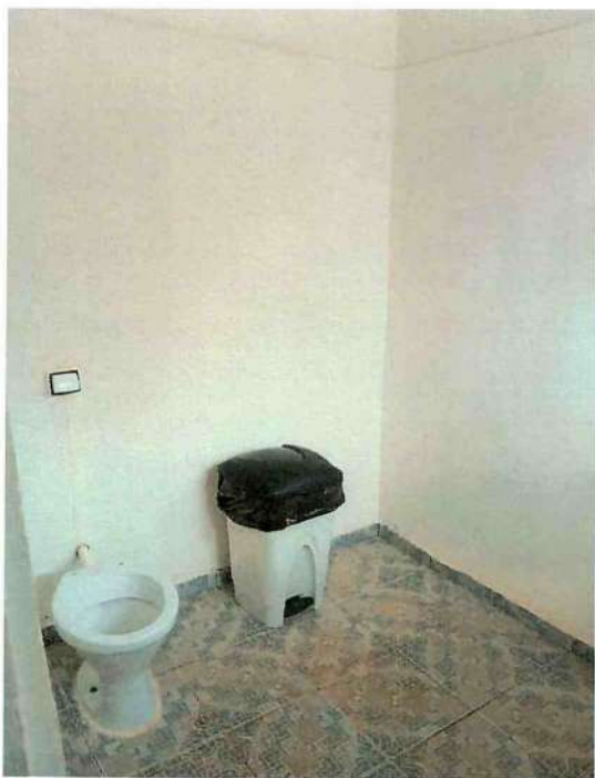
Imagem 1: Banheiro dos funcionários
