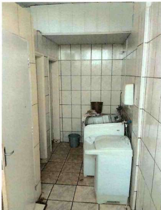
Imagem 3: Banheiro Masculino com lavanderia no seu interior
